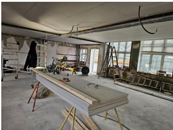
November 2024. Etageadskillelsen er kommet op, og væggene isoleres. Foto: Mai-Britt Just
